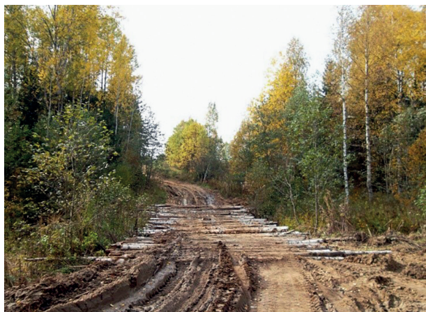
Рис. 8. Дорога лежневого типа (Островский район)
