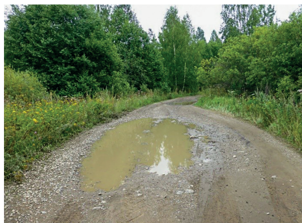
Рис. 5. Дорога с щебеночным покрытием (Костромской район)
