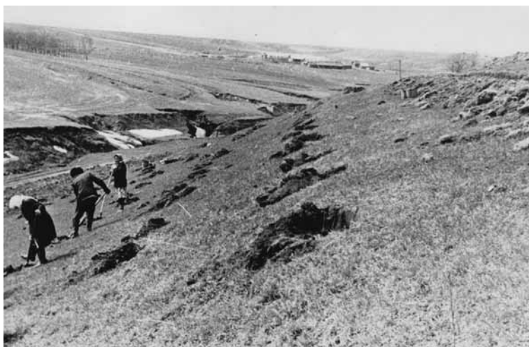
Рис. 5. ОБС «Никольская». Подготовка террас вручную с одновременной посадкой сеянцев на крутосклонах (1976 г.)
