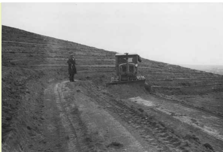
Рис. 3. Устройство нарезных террас прямым террасированием террасером ТР-2 в ОБС «Кишангер» под руководством Ч. С. Хасанкаева (1971 г.)
